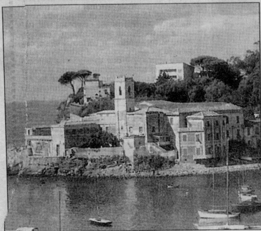
Il complesso dell'Annunziata dove avrà sede il centro culturale
